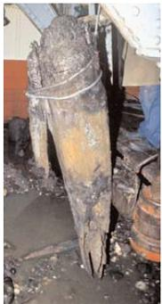
Blick in die Tauchglocke des Schiffes *Krokodil*. Die Glocke ist bereits abgesenkt, das Ziehen der Pfähle hat begonnen.
