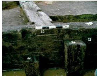
Detail der Holzkonstruktion der hölzernen Kaimauer mit senkrechten Pfosten (z.B. Nr. 54) und querliegenden Balken (Nr. 73). Der verzapfte Balken (Nr. 42) dient zur Stabilisierung der Kaimauer.
