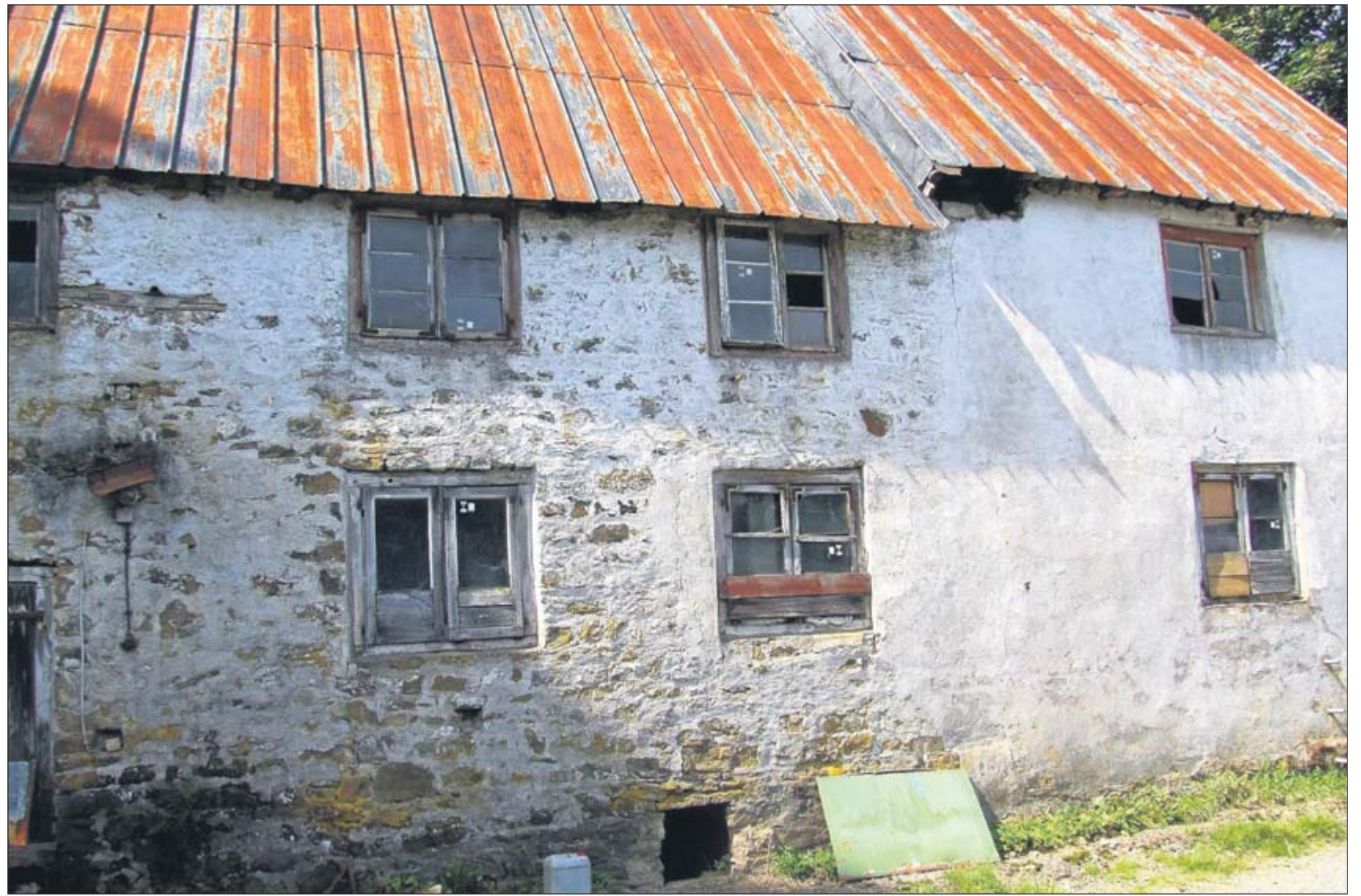
Prägend für die Ostseite des alten Schürfelder Bauernhauses sind die zahlreichen Fensteröffnungen. Ursprünglich aus Fachwerk errichtet, kamen die Mauern aus Bruchsteinen mit Verputz vermutlich erst im Laufe des 18. Jahrhunderts hinzu. • Fotos: vom Hofe
