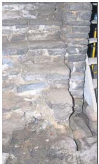
Diese steinerne Treppe führte vom Wohnbereich zum Stall.
